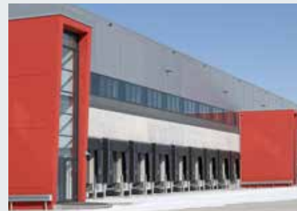
Immogate Logistikcenter, Múnich
